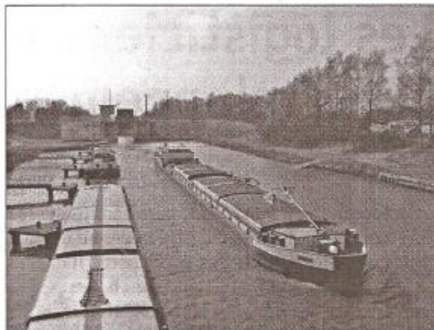
Tout le monde attend le démarrage des travaux du grand canal Seine-Nord (ici, l'écluse n°2) à Marquion.
